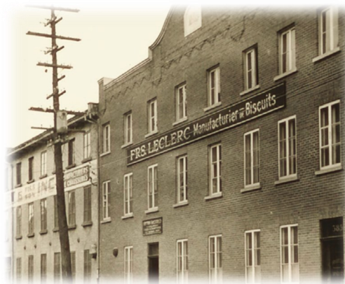
L'usine sur la rue Saint-Vallier à Qué-
